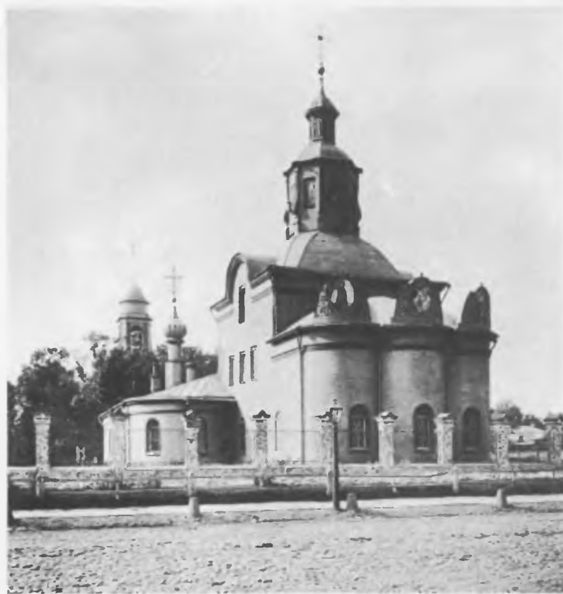
Церковь Троицы на Капельках (1719) — разрушена
