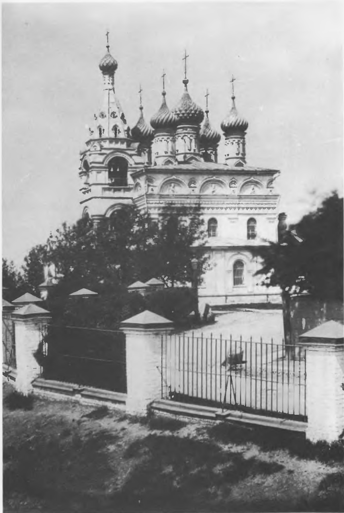
Церковь Введения (XVII в.) — разрушена
