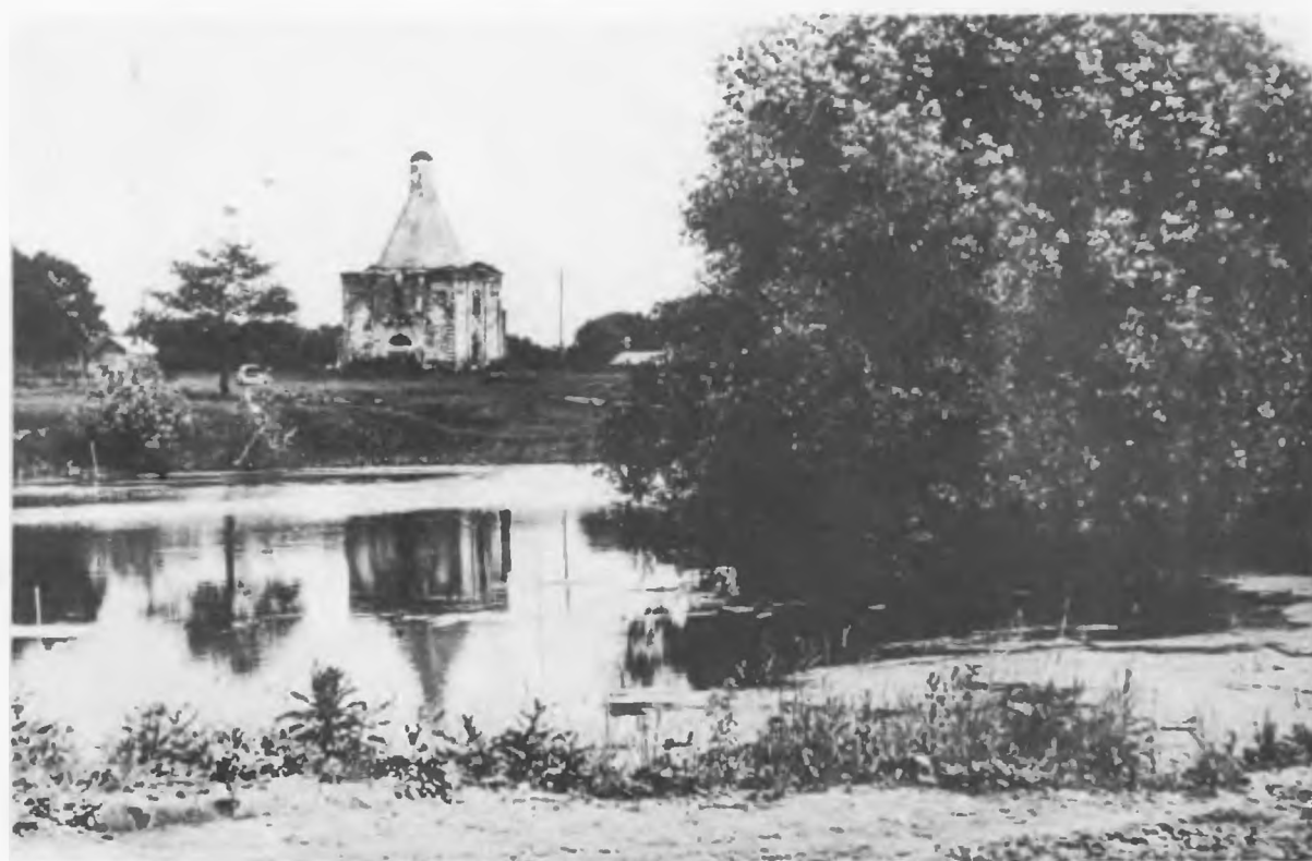
Ильинская церковь (XVI в.), с. Прусы Московской обл.
