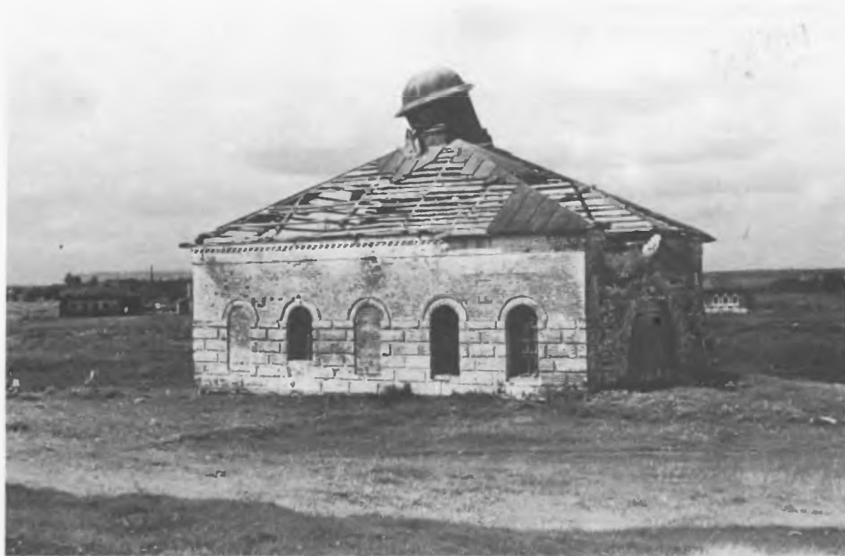
Теплая церковь (XIX в.), с. Семеновское Владимирской обл.
