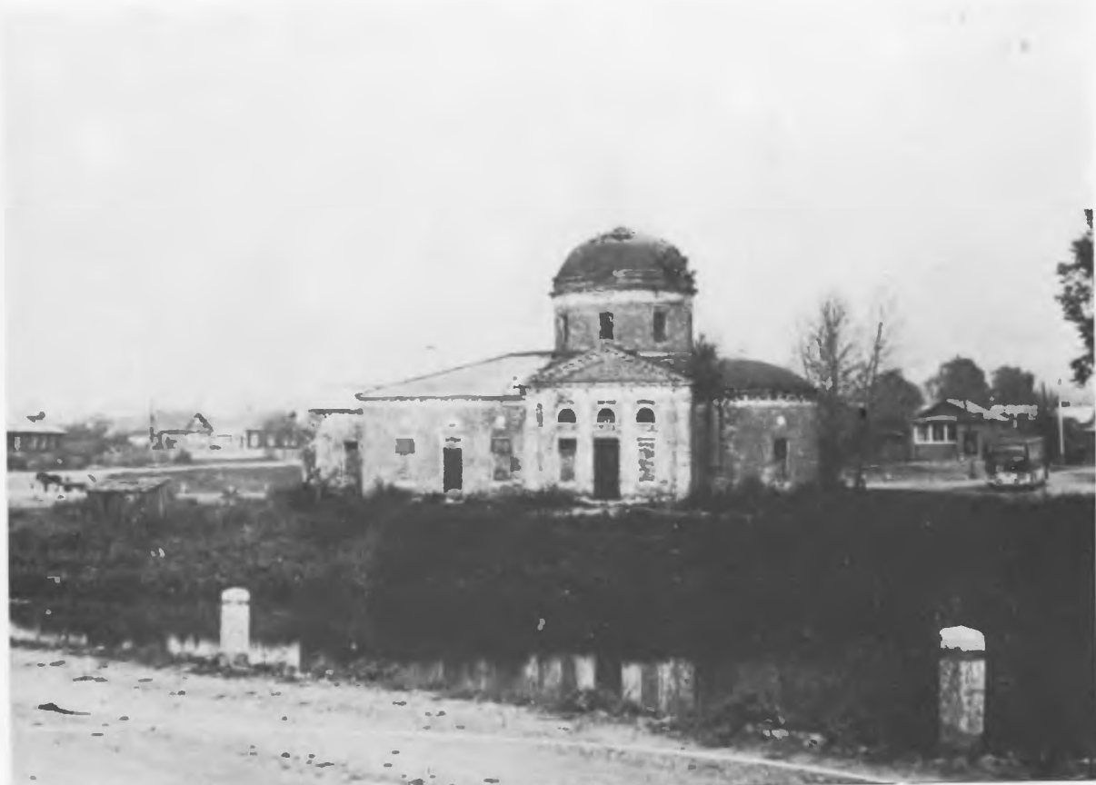
Георгиевская церковь (1839), с. Алешино Московской обл.
